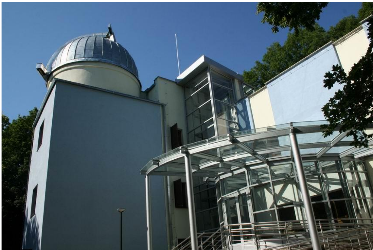
Az épület főbejárata
